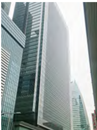
④JPタワー名古屋 竣工年月日:2015年11月
