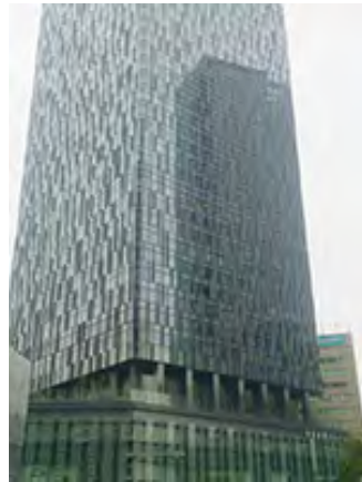
②大名古屋ビルヂング 竣工年月日:2015年10月
