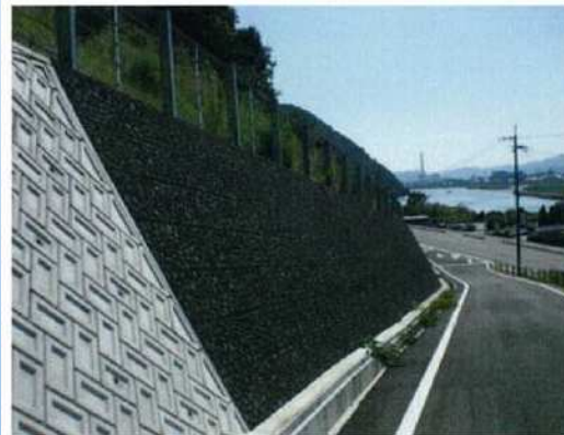
駆け上がれない擁壁
