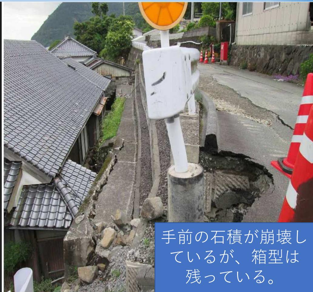
手前の石積が崩壊しているが、箱型は残っている。
