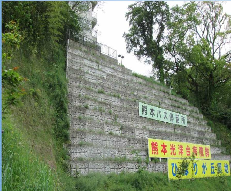
周辺道路の路面が地震の衝撃により破損していたが、箱型擁壁には異常なし。
