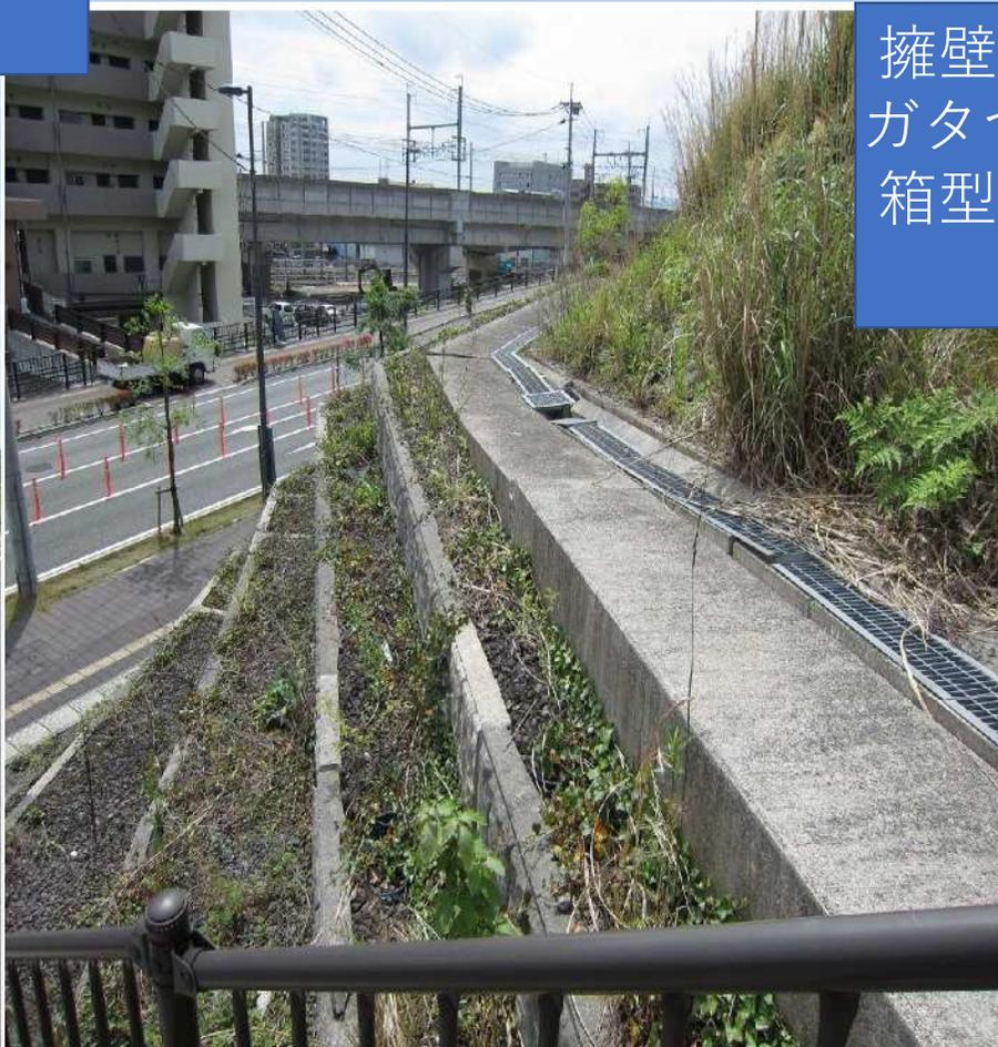
擁壁の上の側溝はガタついているが、箱型擁壁には影響なし。
